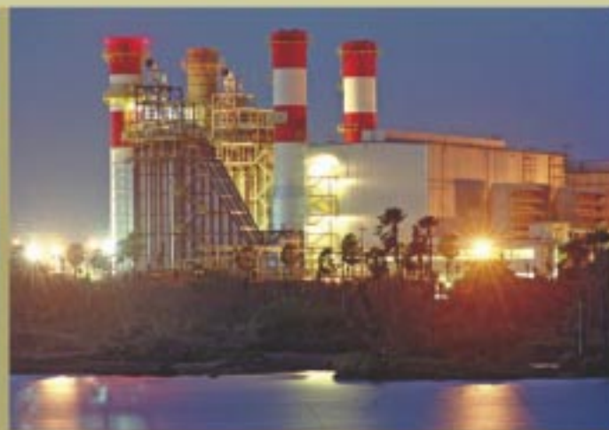
Termelétrica de Fortaleza (CE)
