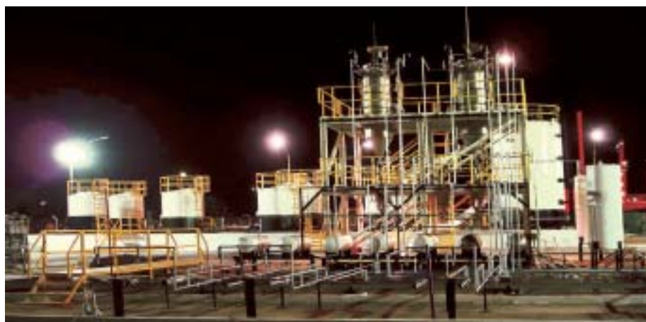
Planta piloto da usina de biodiesel da Petrobras em Guararé, Rio Grande do Norte.
